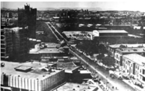
100. Yıl Çarşısı inşaatı
