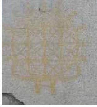
Doğukent Bulvarı üzerinde, heyelanı önlemek için yapılan duvarlarda sağlı sollu olarak yaklaşık 70 adet saydık.
